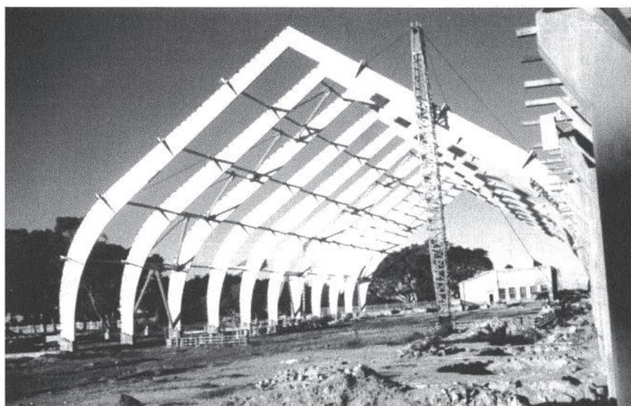
Fig. 2.18 Pórtico triarticulado de hastes curvas em madeira laminada e colada.
