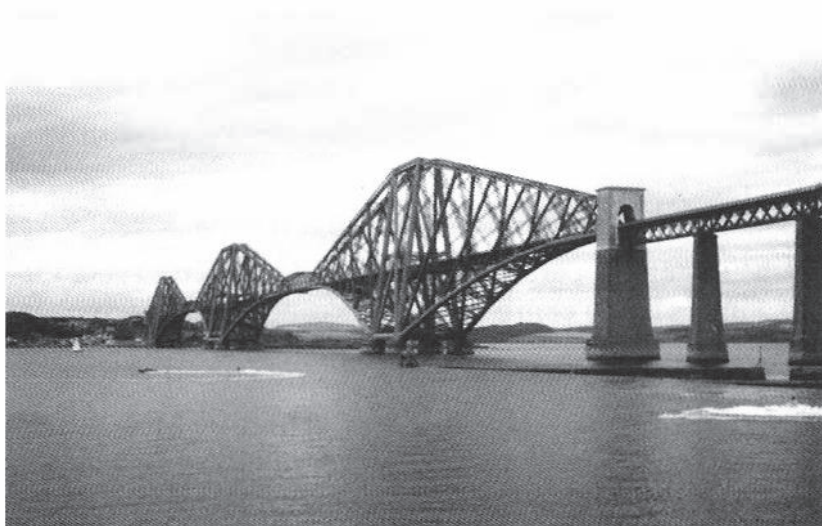
Fig. 1.5 Ponte Firth of Forth, na Escócia, construída em 1890, foi recorde mundial de vão livre: 521 m. (Foto do Autor.)
