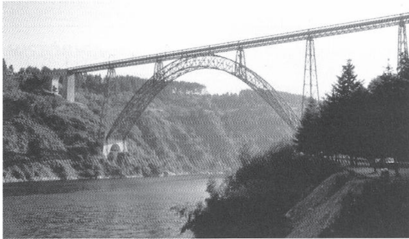
Fig. 1.3 Viaduc de Garabit, Sul da França, com 165 m de vão, construída por G. Eiffel em 1884. (Foto do Autor.)
